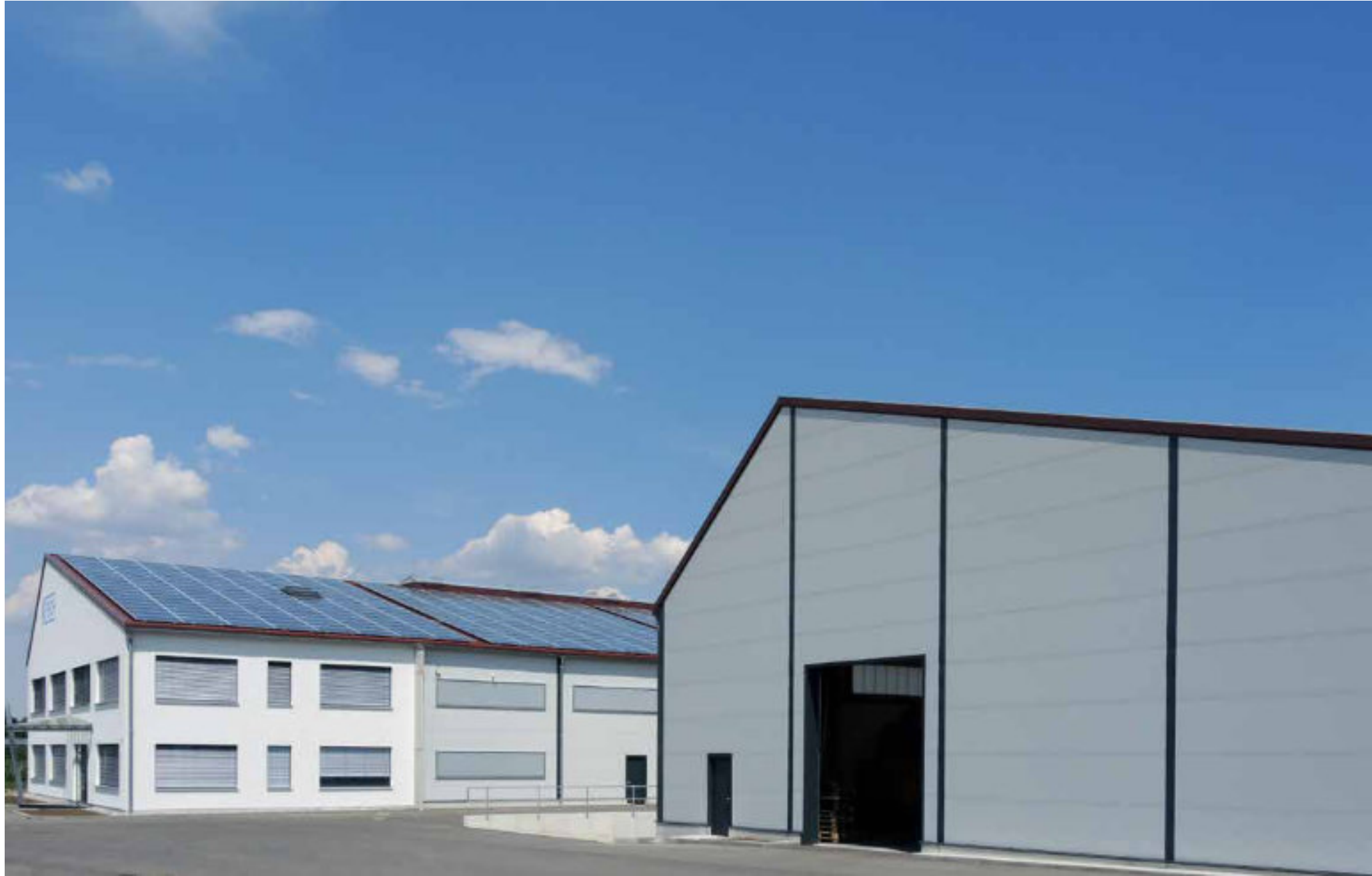
Durch das versetzte Satteldach und die Fenstereinteilung erhält das Bürogebäude in Holzbauweise seine Individualität.
